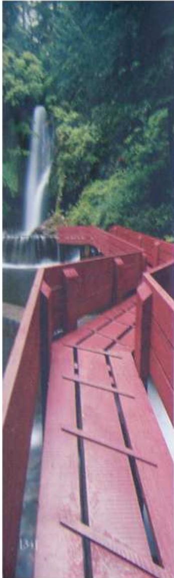
Una rampa de módulos de cobertal fue construida siguiendo el curso de la quebrada, a la larga de 450 metros, para llevar con seguridad al visitante hasta las termas.
