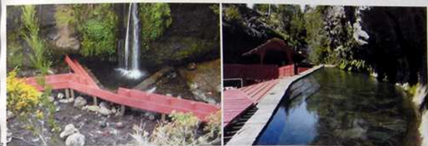
1- Las piscinas están en una quebrada de 450 metros de largo. Para ir de una a otra se hizo una pendiente zigzagante de más de 500 metros. Sobre el techo de las vestidores se puso pasto / 2- El arquitecto quiso manejar una redonda simple, rústica, dentro de la geometría del paisaje. Usó madera para los pasadizos y las piscinas. / 3- La mayoría de las piscinas tienen un borde natural de roca y otro realizado por los arquitectos con la misma piedra que se puso en el fondo de la piscina.
